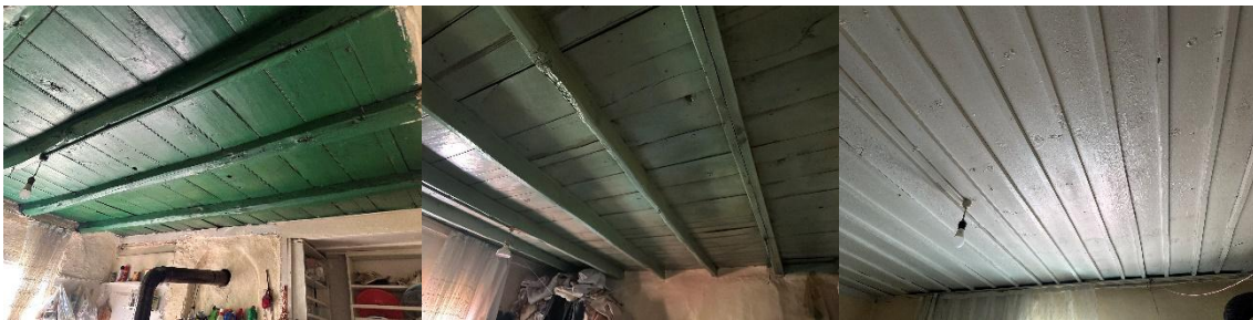
Şekil 12. Özmenler Evi iç mekân tavan kirişi ve kaplama örnekleri
