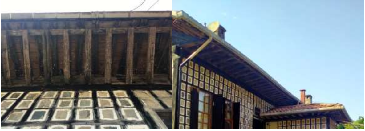
Şekil 4. Konak Çatısının Giriş Cephesinden Görünüşü
