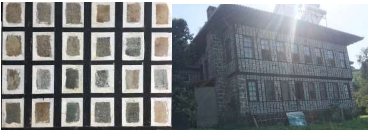
Şekil 2. Cephede Kullanılan Göz Dolma Tekniği ve Yapının Ön Cephesi
