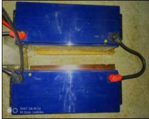
Şekil 11. Seri bağlı 12V 150Ah jel batarya grubu
