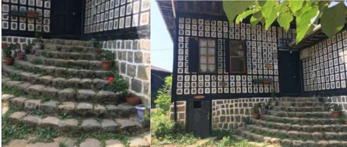
Şekil 4. Konak Giriş Merdiveni ve Merdivenin Cephe ile Görünüşü
