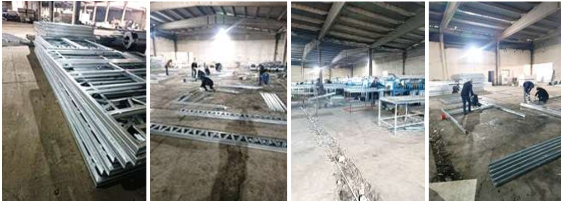
Şekil 7. Profillerin panel haline getirilmesi (Bekçi,2025)
