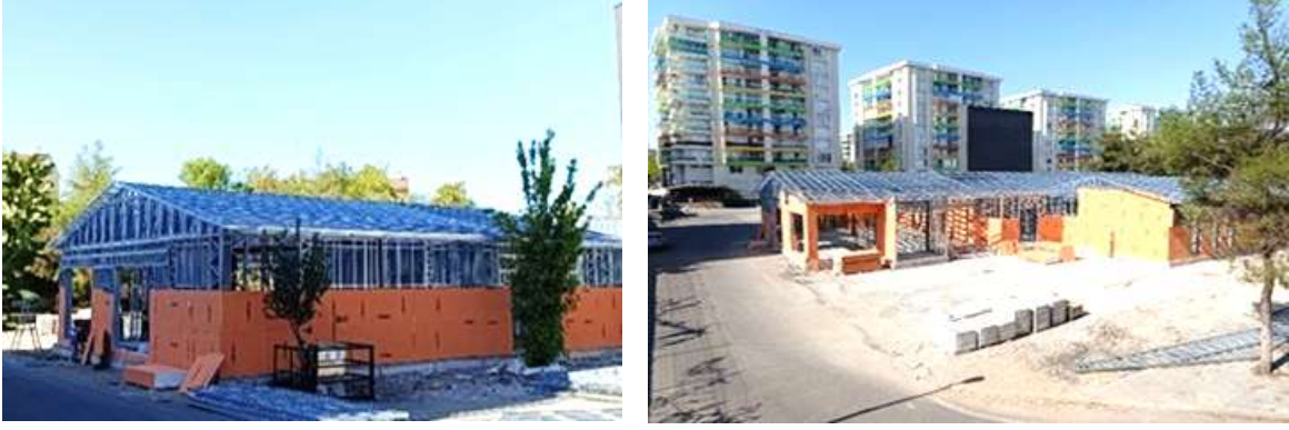
Şekil 8. Çelik panellere levhalar ile kaplama yapılması (Bekçi,2025)
