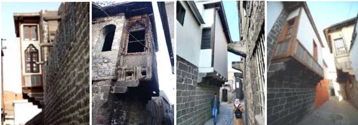
Şekil 6. Geleneksel evlerde saçaklarda ahşap detaylar
