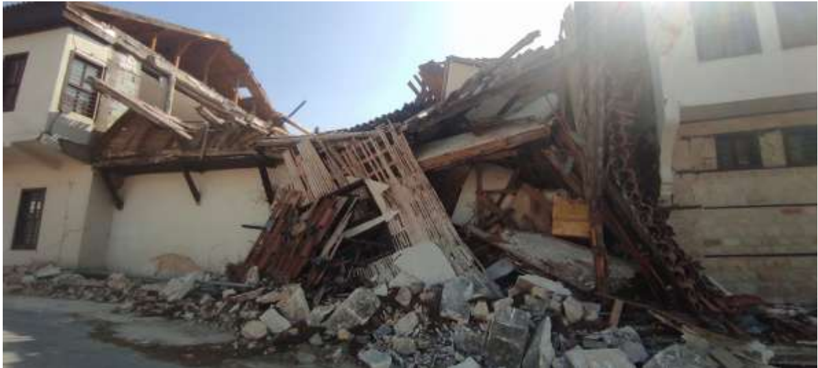
Şekil 9: Depremlerde ağır hasar alan geleneksel ahşap ağırlıklı yapı.
