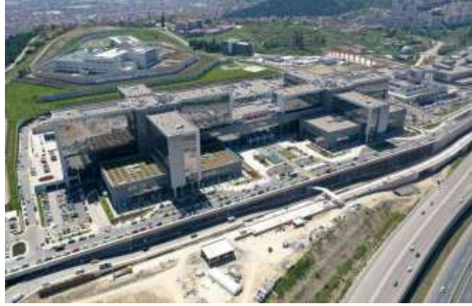
Şekil 2. Kocaeli Şehir Hastanesi'nin Havadan Görünümü
