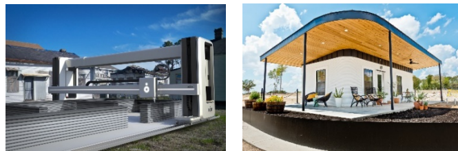
Görsel 5. Ev inşasında kullanılan 3D yazıcı (sol) ve yazıcı aracılığıyla üretilen sonuç ürünü (sağ) (archdaily.com).
