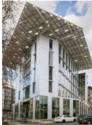
Şekil 2.3. Bullitt Center (Hanford, 2015)
