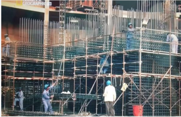
Resim 30: Bina Kafeslerinin Yapılması
