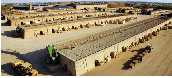
Şekil 2.1. Hoffman tipi sistemli bir tuęla fabrikası
