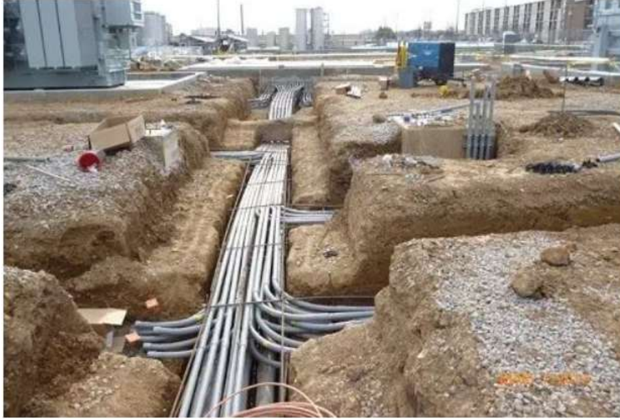
Resim 4. Yüksek riskli bölgelerde kullanılan yeraltı kabloları (Admin, 2020)
