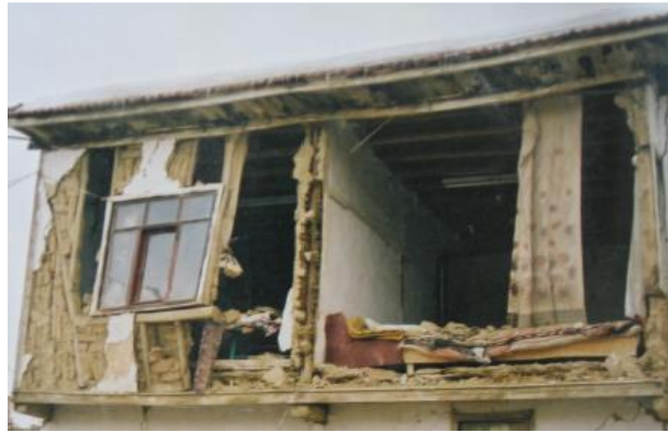
Şekil 12. Bağdadi sistemle inşa edilmiş yapıda deprem hasarı örneği (Korkmaz, 2007: 63).
