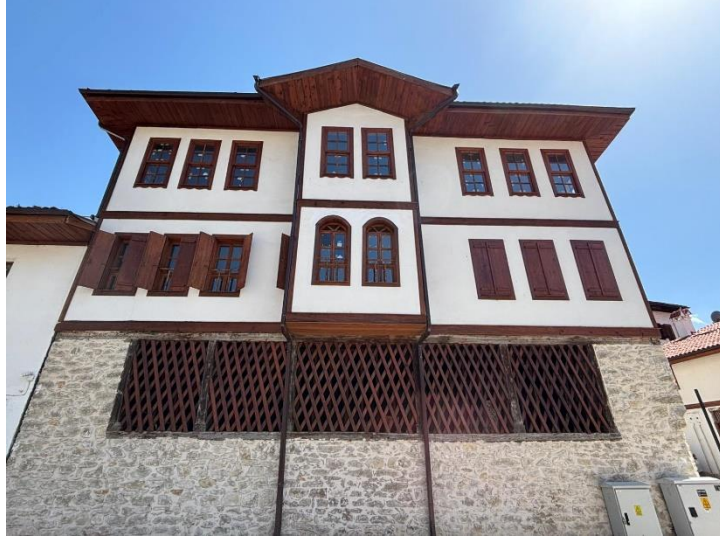
Şekil 7. Glisteli sistemin çapraz ahşap elemanlarla oluşturulan muşabak formu
