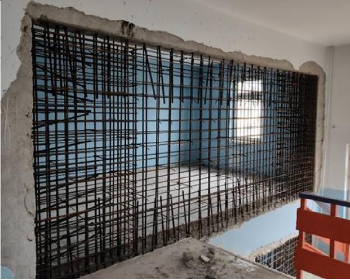
Şekil 3. Taşıyıcı sisteme yeni perde ilave edilmesi.
