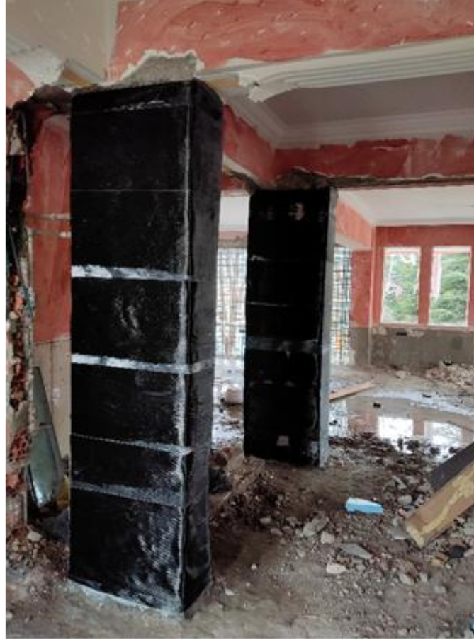
Şekil 4. Kolonların lifli polimerler (FRP) ile sarılması
