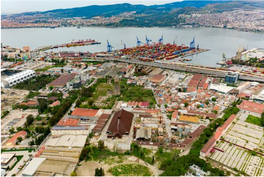
Şekil 4. Mangır, 2021. Liman Arkası Bölgesi Genel Görünüşü
