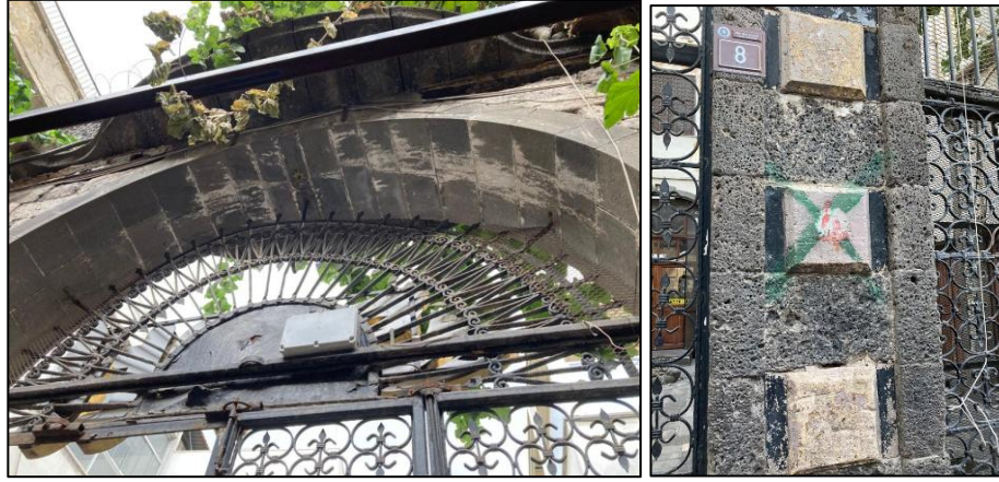
Şekil 14. Avlu giriş kapısının kemer bölümünde ve taş yüzeyinde meydana gelen yüzey kirlilikleri ve tuzlanmalar (2022)
