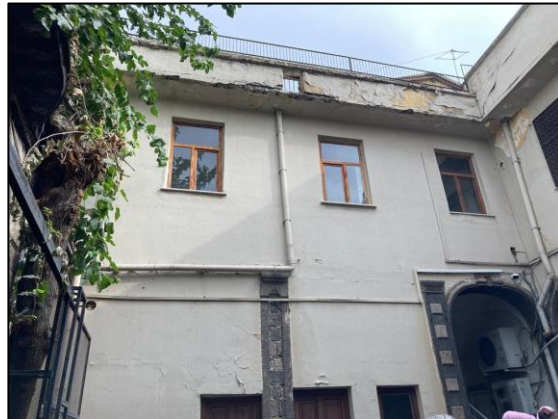
Şekil 19. Birinci kata eklenen betonarme ek (2023)
