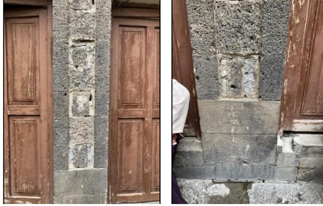
Şekil 12. Cephedeki sütunlarda meydana gelen oyuklanmalar (2023)
