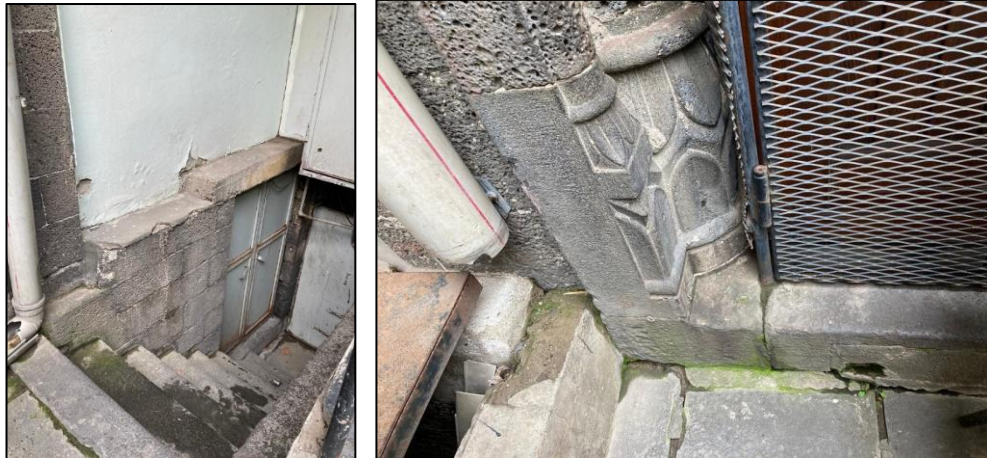
Şekil 15. Zemin Döşemelerinde Meydana Gelen Biyolojik Oluşumlar (2023)
