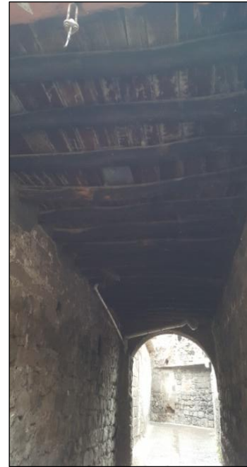
Şekil 5: Kırkdirek Sokak’ta bulunan betonarme ek yapılan “kabaltı” ile Sülüklü Sokak’taki “kabaltı”ya eklenen tesisat borusunun yarattığı hasarlar (Budak, 2023)
