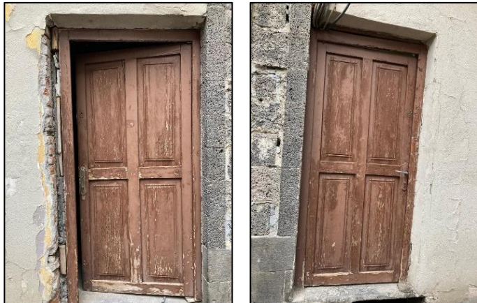
Şekil 17. Ahşap kapılarda meydana gelen aşınma ve renk değişimleri (2023)
