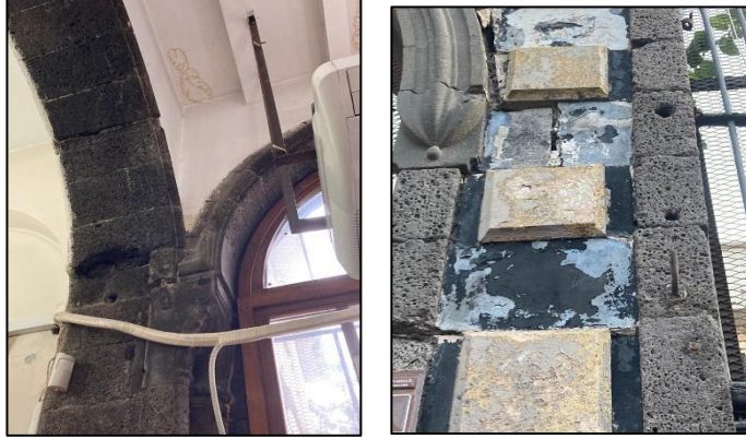
Şekil 16. Bazalt yüzeylerde çevresel elemanların etkileriyle meydana gelen bozulmalar (2023)
