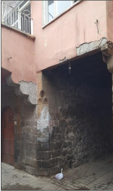
Şekil 5: Kırkdirek Sokak’ta bulunan betonarme ek yapılan “kabaltı” ile Sülüklü Sokak’taki “kabaltı”ya eklenen tesisat borusunun yarattığı hasarlar (Budak, 2023)
